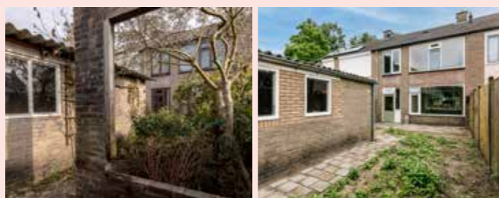
Raamkozijnen in de schuur voor (links) en na de renovatie (rechts)
